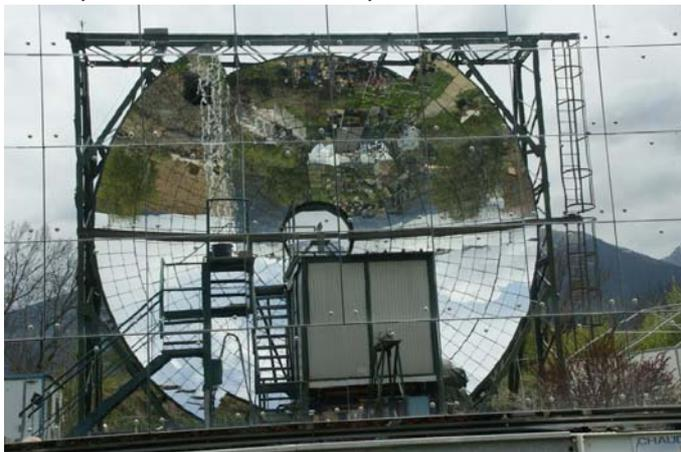
*– un miroir géant de 141 m<sup>2</sup>, l'**héliostat**, composé de 567 miroirs plans, reçoit les rayons solaires et les renvoie vers une **parabole** de 100m<sup>2</sup>, composée de 860 miroirs concaves*
